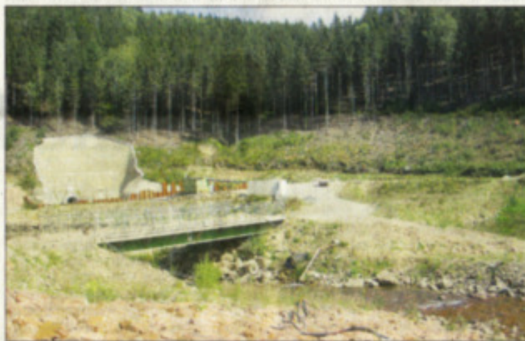
Blick über die Vorsperre der Talsperre Klingenberg zum Einlauf für den Entlastungsstollen. Der bekommt in den nächsten zehn Monaten eine Regulierung für den Einlauf.
